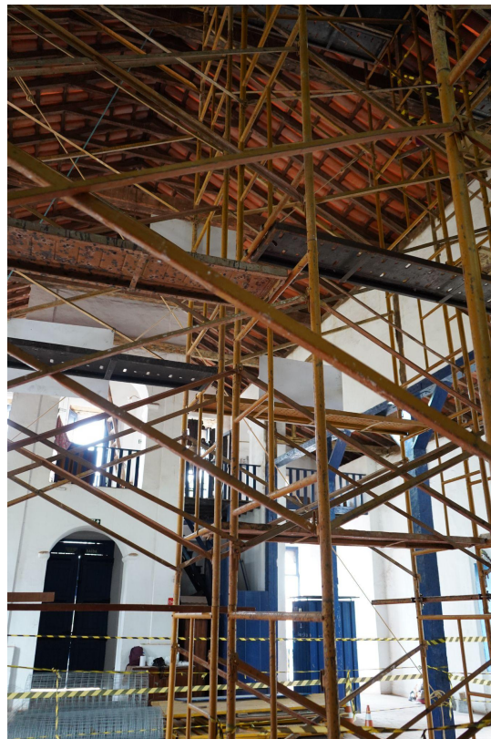
Escoramento interno do trecho abaulado do telhado da Igreja de Nossa Senhora do Rosário, em Paracatu/MG.
