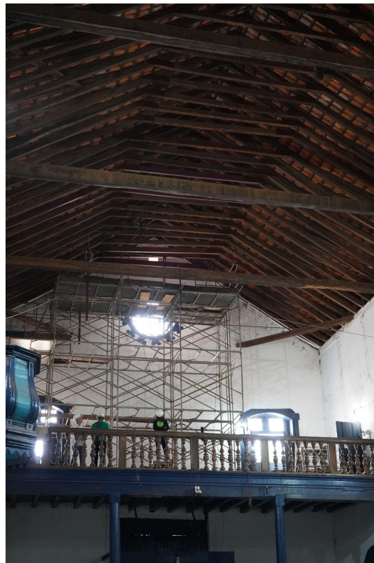
Vista interna a partir do piso da nave do telhado da Igreja de Santo Antônio, em Paracatu/MG.
