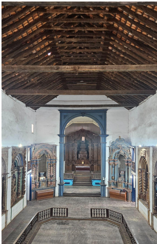
Vista interna a partir do coro do telhado da Igreja de Santo Antônio, em Paracatu/MG.
